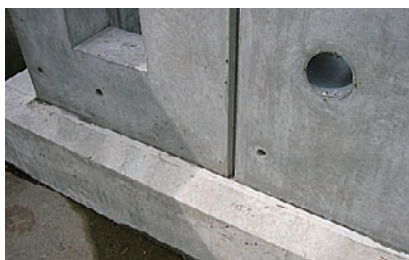
シリカフェーム混入高強度コン打上り面
