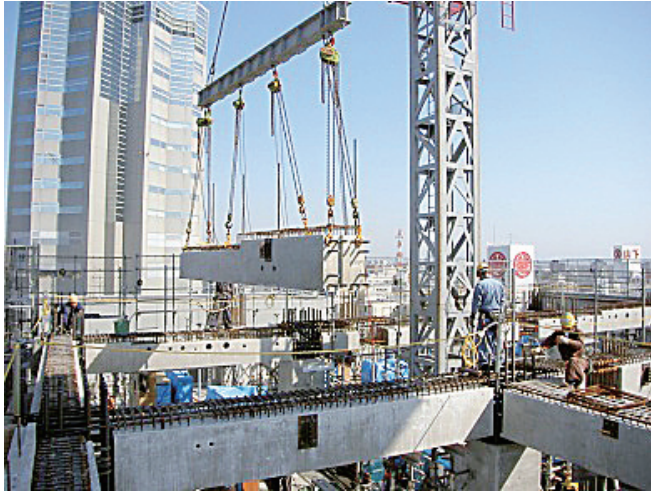
効率的な施工(プレキャスト工法)
