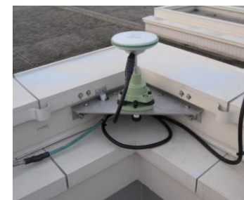
屋上GPS設置状況
