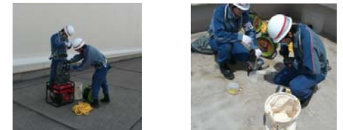
作業確認の様子
