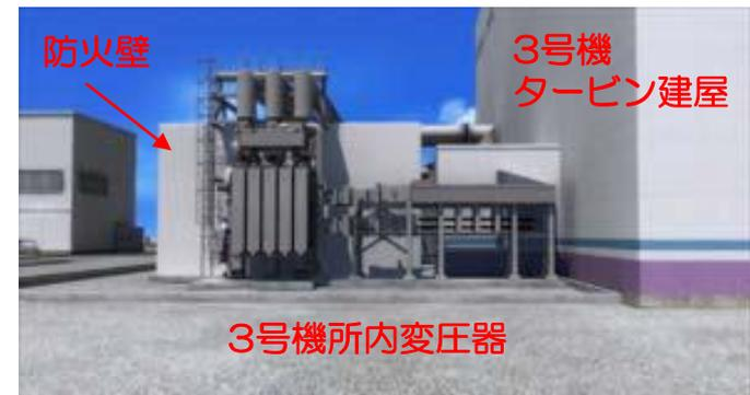
図 側面から見た変圧器とタービン建屋の関係
