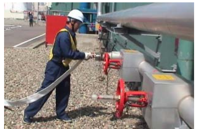
消防ホースの注水ライン接続
