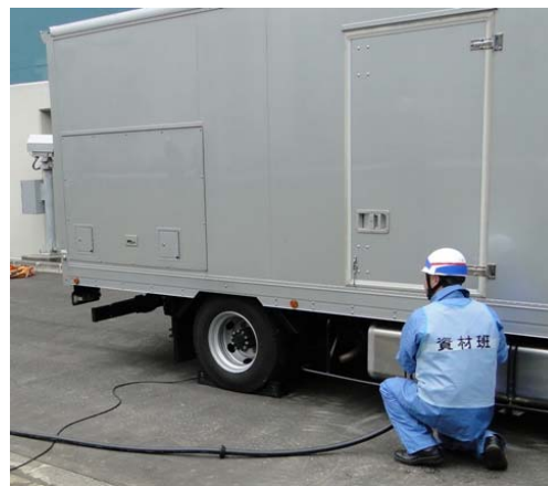
電源車へのケーブル接続
