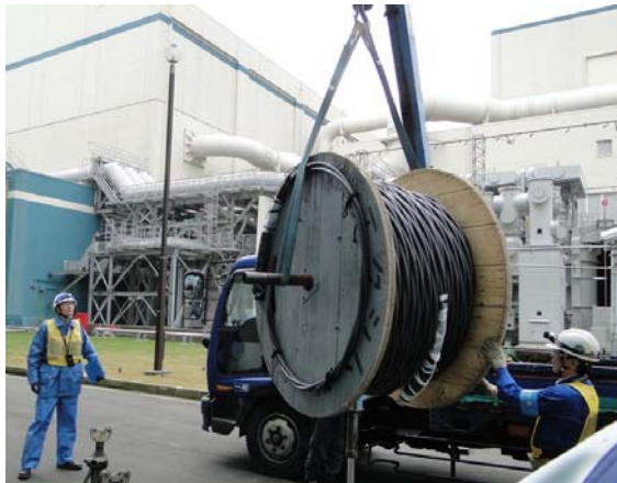
仮設ケーブルの準備
