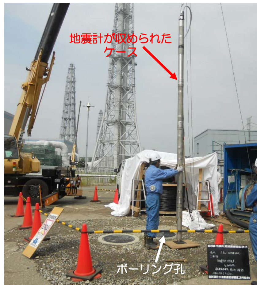
【地震計埋設工事の実施状況】
