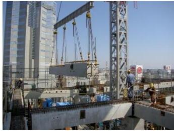
効率的な施工 (プレキャスト工法)
