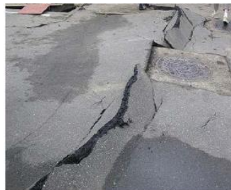
2007年中越沖地震による柏崎市中心部道路の地盤変状(左)と中心部の三次元地盤構造(右)
