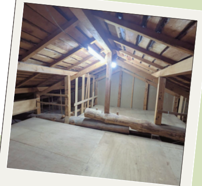
2階には屋根裏部屋も！
