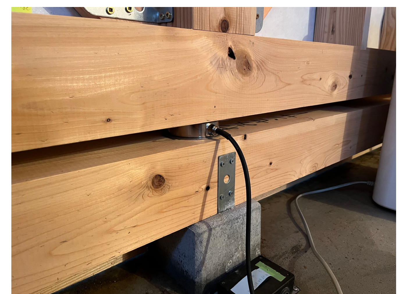
基礎と柱の間に取り付けられた荷重計
