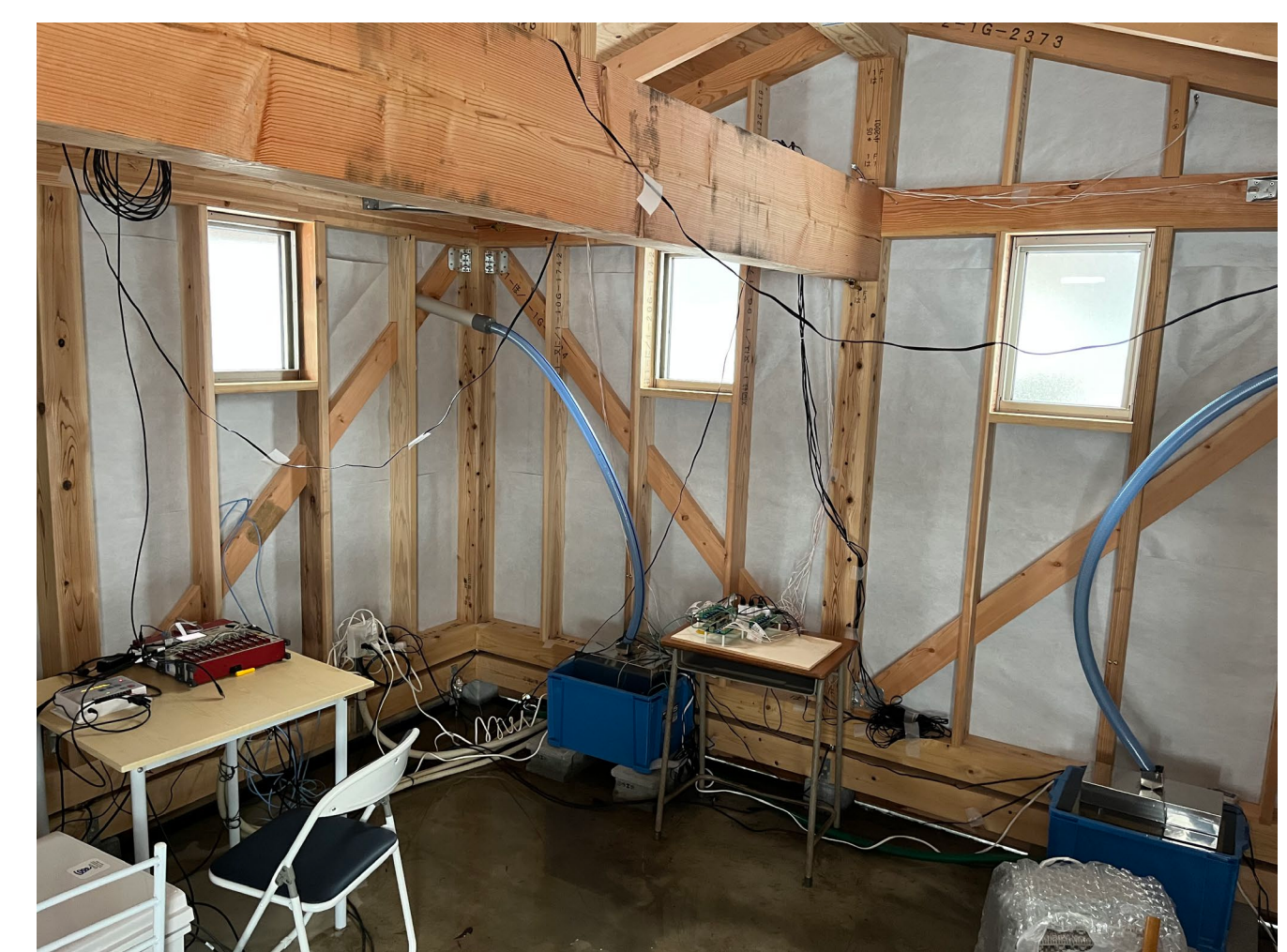
実験棟の内部
