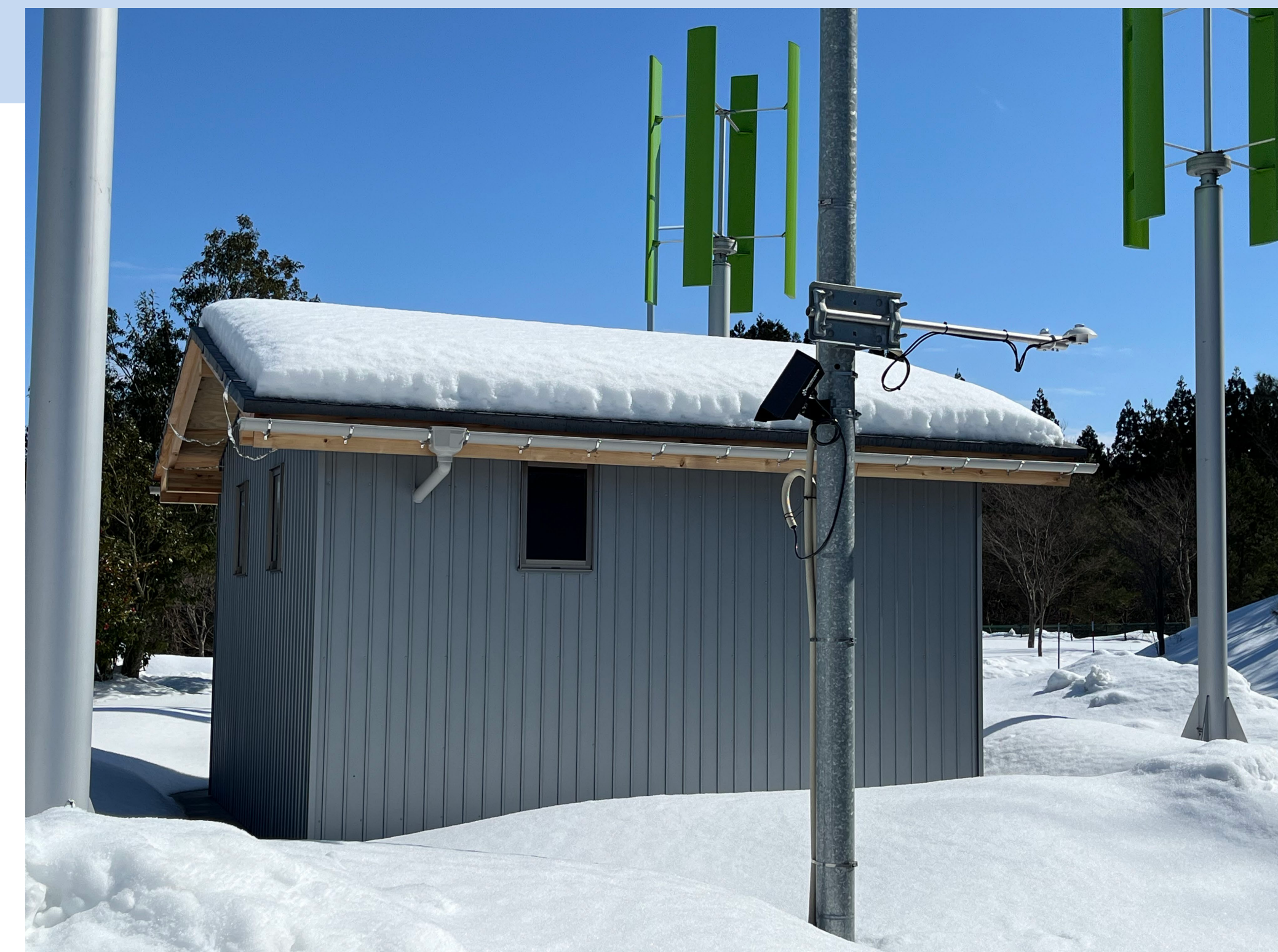
2024年12月に新潟工科大学構内に建設された準実大実験棟
