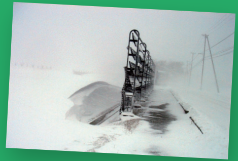
防雪柵周りの雪の吹き溜まり
