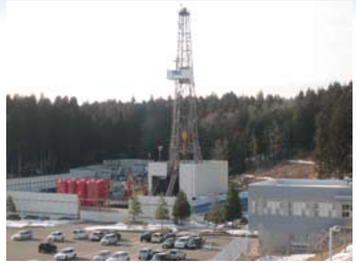
工事の状況 (平成23年2月現在)
