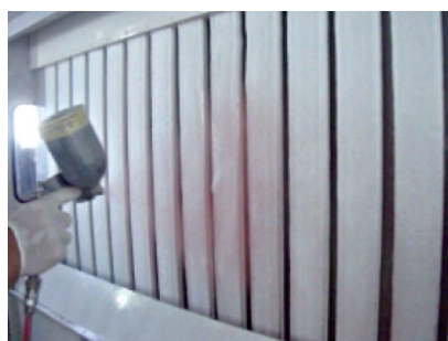
塗装作業状況
