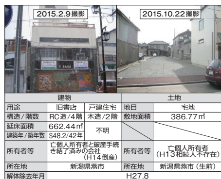
図2 危険空き家の概要と外観・跡地写真(燕市)
