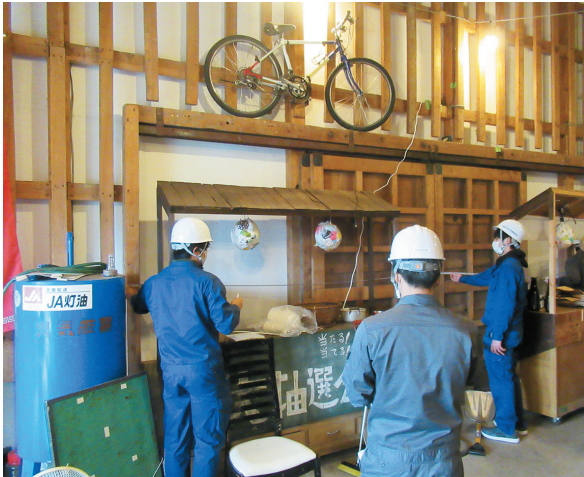
9 木造倉庫の現地調査の様子
